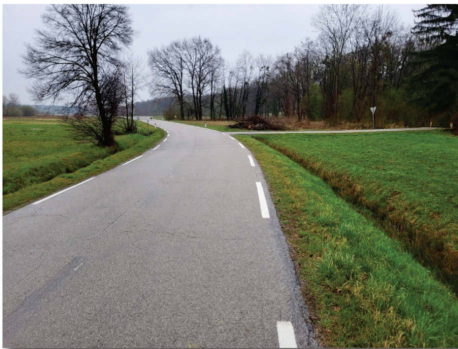
Slika 9: Tipičen odsek ceste kjer se dosežajo visoke hitrosti, brez pločnika in kolesarske steze
