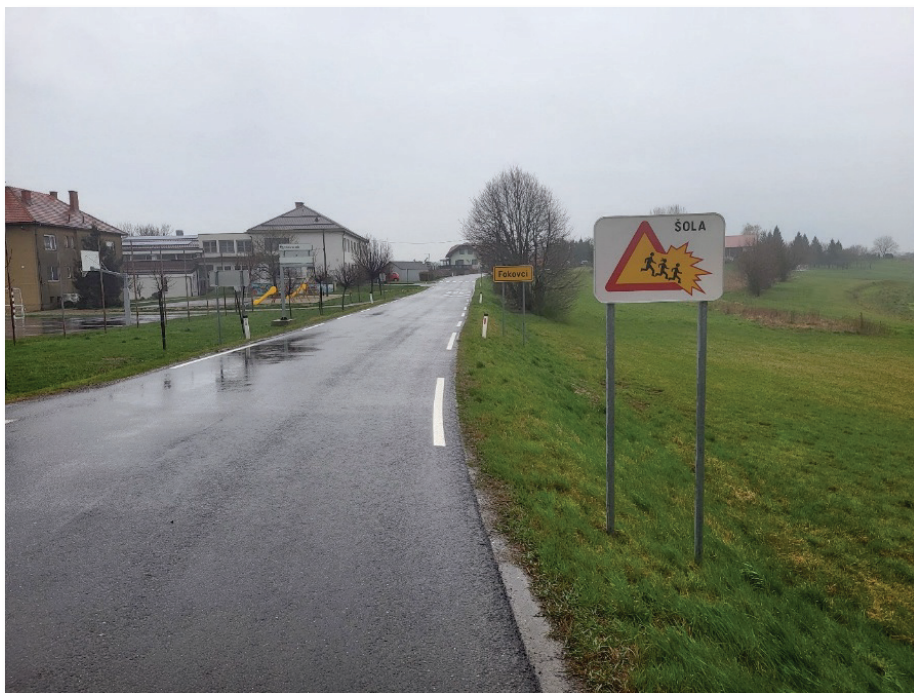
Slika 10: Cesta pri vrtcu v Fokovcih. Ni pločnikov, ni prehoda za pešce
