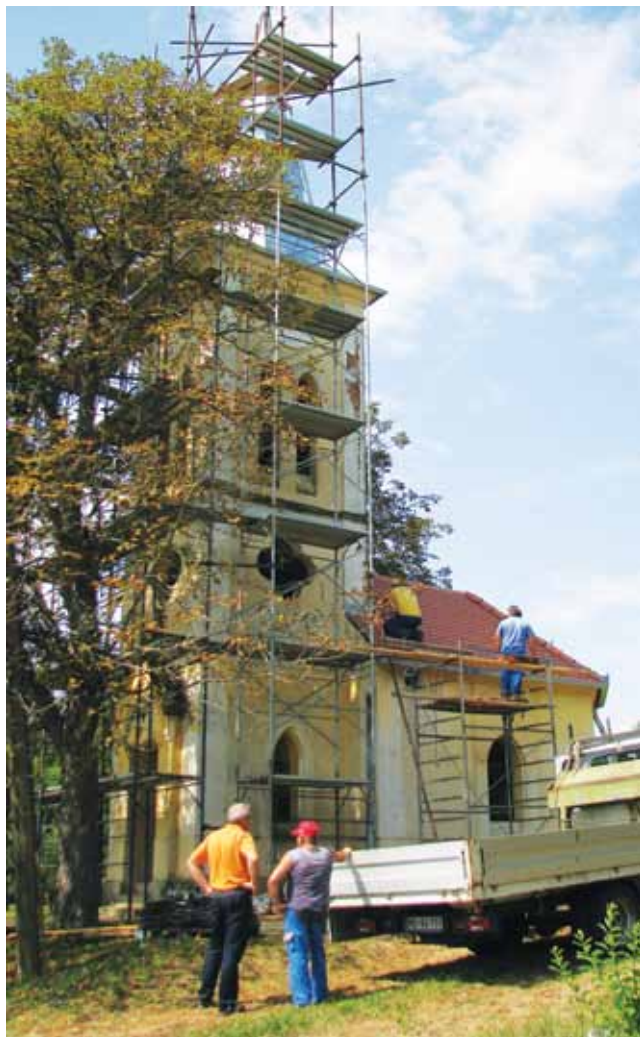
Berkovska evangeličanska cerkva je dobila novo streho, kmalu pa tudi novo »obleko«.
