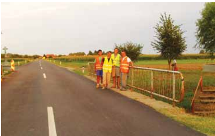
Ograja še pred začetkom obnove
